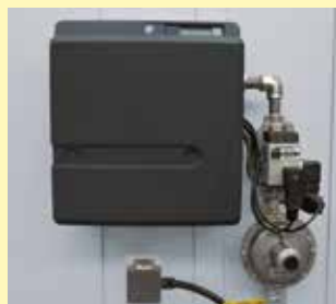
用于至NB 600的标准型的紧凑型燃烧器
