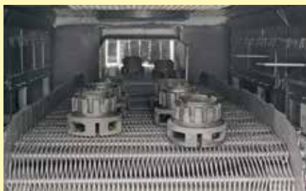
Gliederbandantrieb in einem Durchlaufofen
