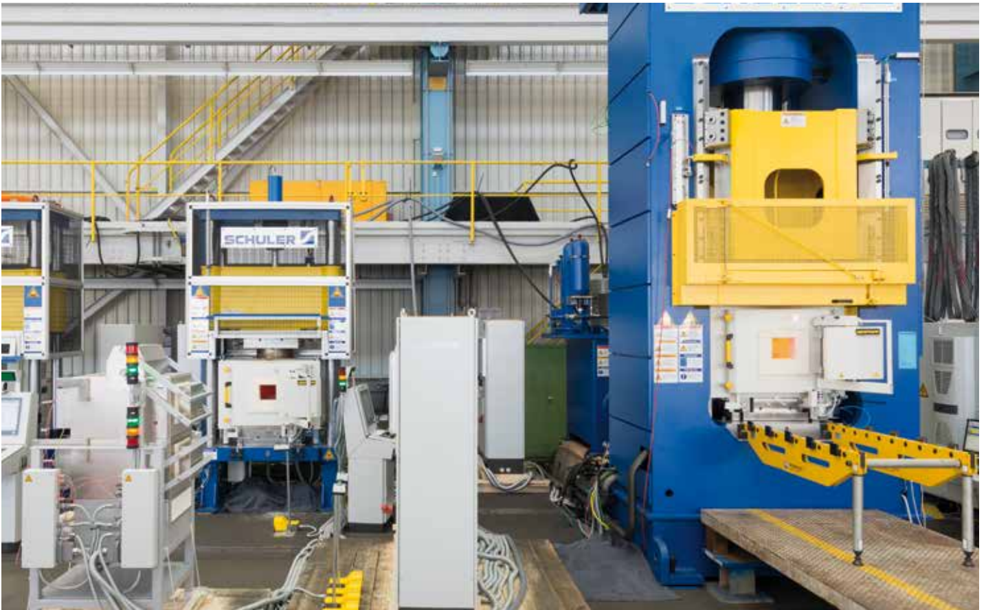
Vorwärmofen zur Beheizung eines Pressstempels in einer Warmumformungsanlage
