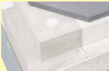
Pasos para termopares (Ø 40 mm) en las esquinas delanteras de la carretilla
